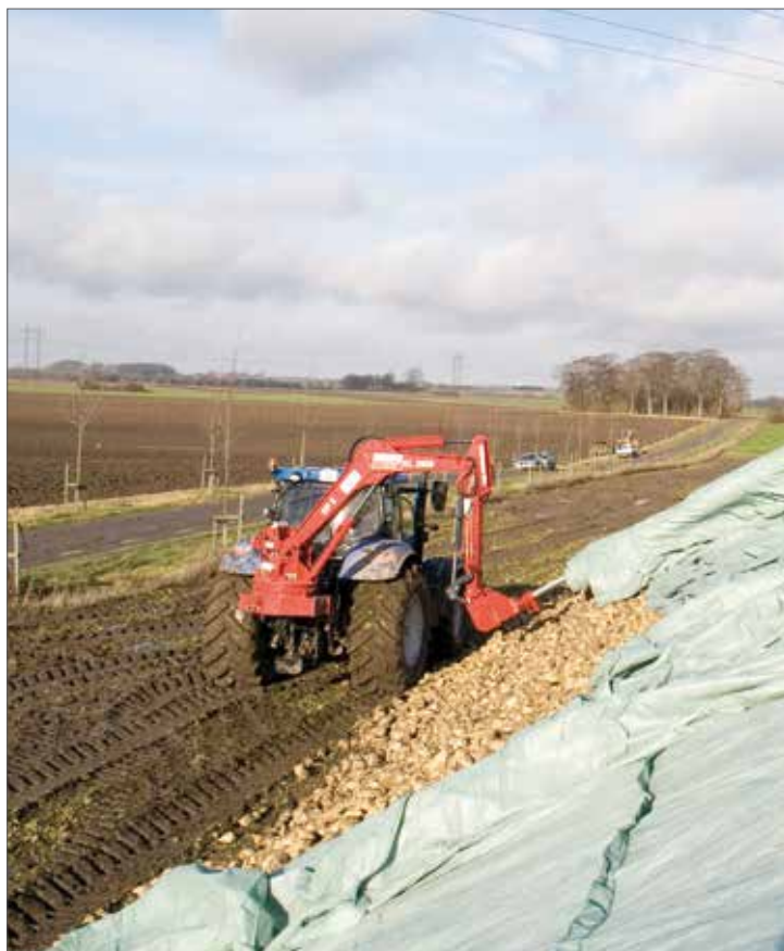
Bild 1: Utläggning av TopTexduken på stukan. Här krävs det lite manuell finjustering av duken innan den slutligen trycks på plats av traktorn. Varje duk är 35 meter lång och räcker i normalfallet till cirka 300 ton betor.
