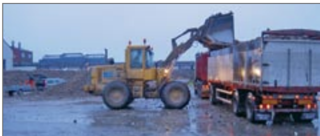
Bild 6. Slutleverans den 10 januari. Betorna lastades direkt utan rensverk.
