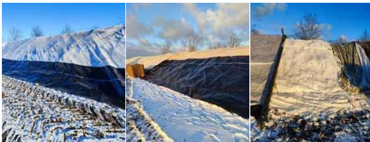
Syddu dukar. De två bilderna till vänster visar två respektive fyra meters Polyfelt-dukar som sytts ihop med Toptex. Bilden till höger visar den skumbeklädda ytan samt till vänster i bild, plast och Toptex som sytts ihop.
